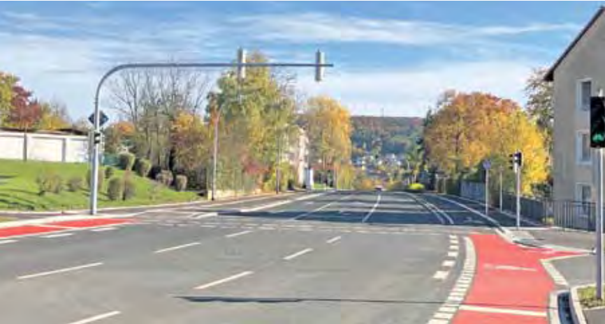
Fertiggestellter Nordring Bereich Pfalzstraße
